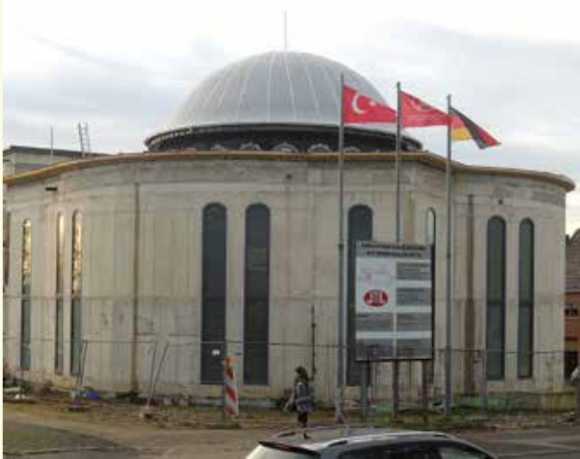
▲ Die Fenster sind eingesetzt, jetzt erfolgt die Fassadendämmung. Fotos: bb
